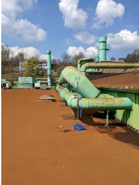
Abbildung 5: Messpunkt 2 (Quelle: BfUL)
