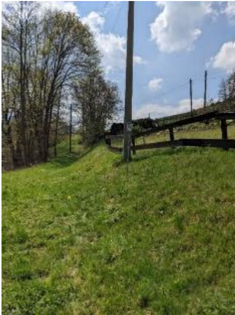
Abbildung 9: Messpunkt 7 (Quelle: BfUL)
