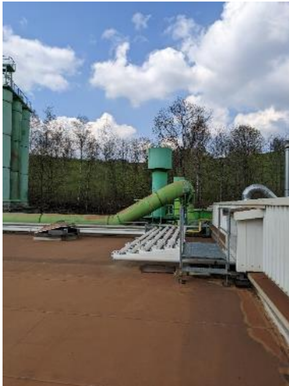
Abbildung 6: Messpunkt 3 (Quelle: BfUL)
