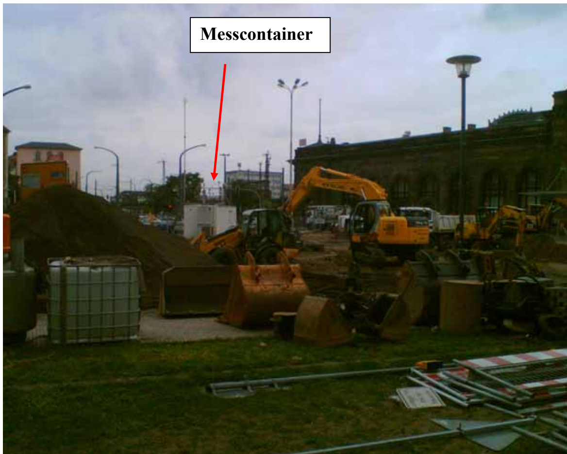
Abb. 2.2.1.1: Sanierungsarbeiten an der Station Dresden Nord
