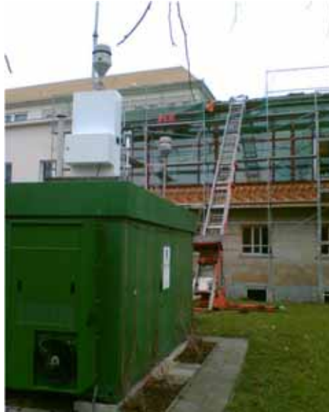
Abb. 2.2.1.2: Sanierungsarbeiten an der Station Dresden Herzogingarten
