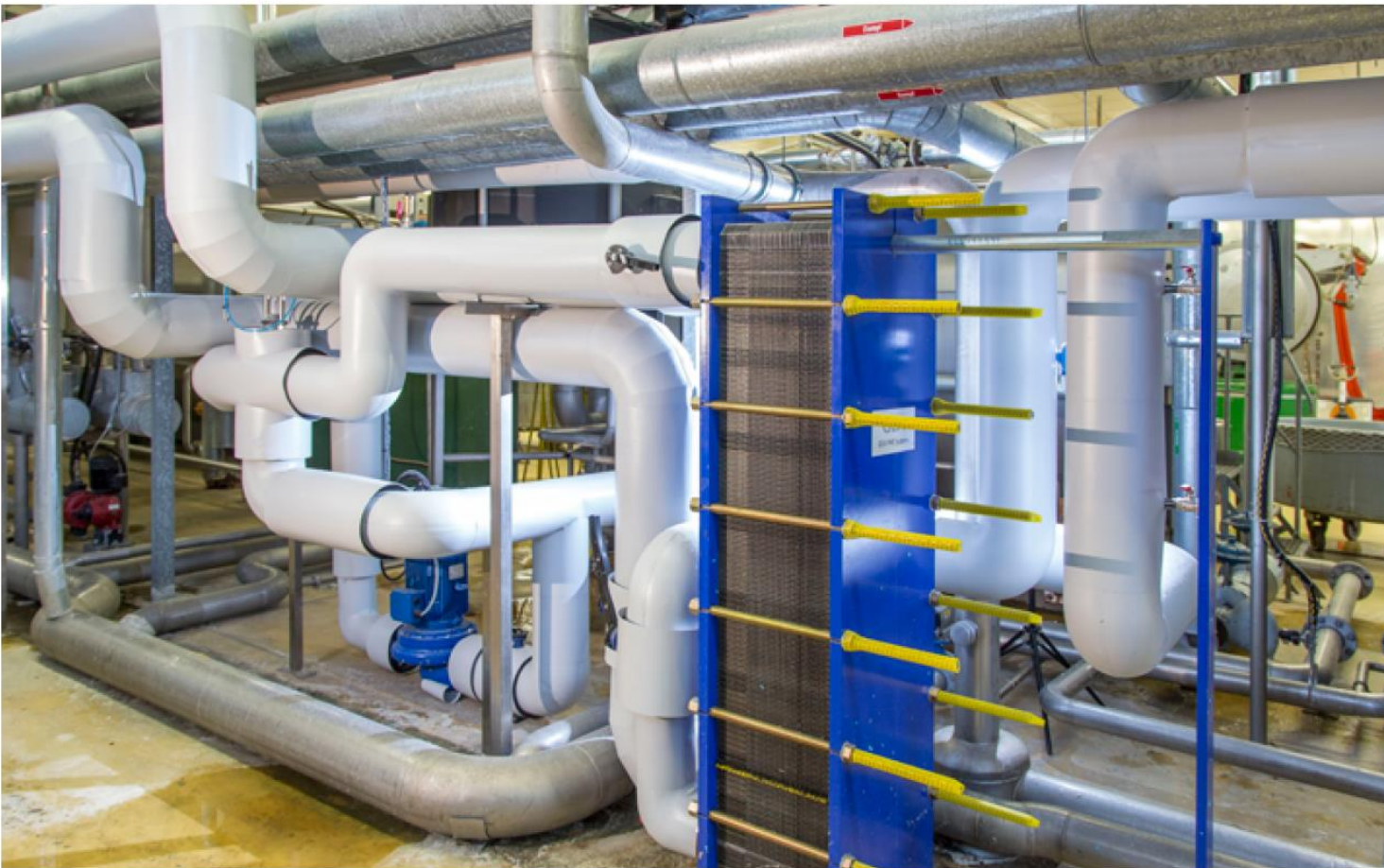
Abb. 2: Nutzung der Abwärme aus einem Blockheizkraftwerk mittels Plattenwärmeübertrager (S. 15) bei Frottana Textil GmbH & Co. KG in Großschönau (Lausitz)
