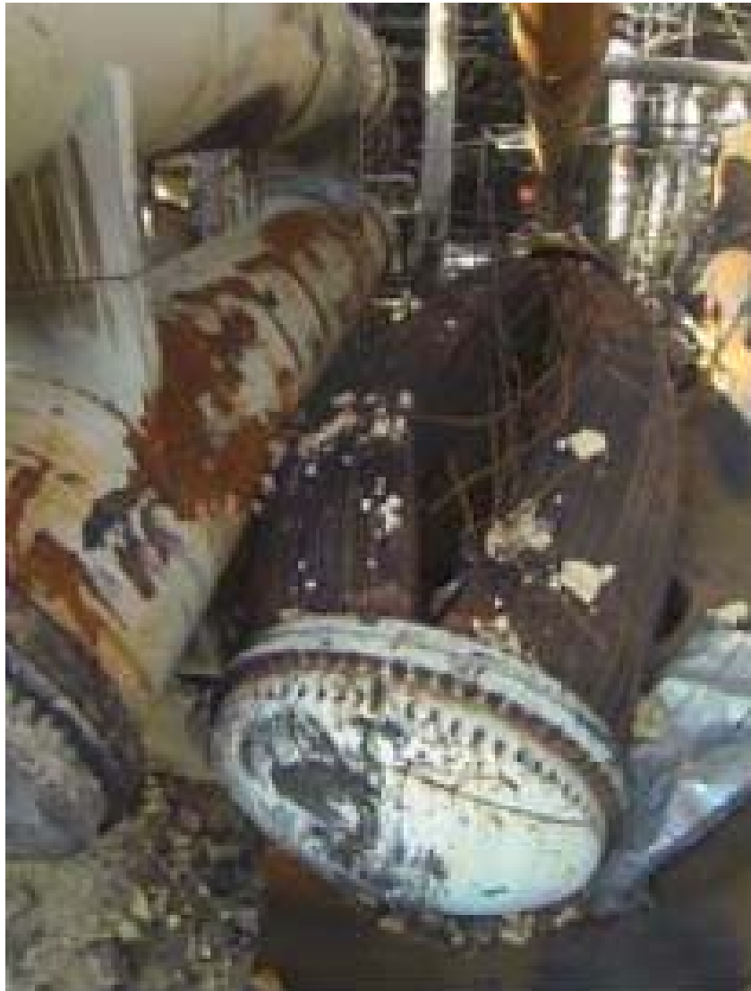
Brandschutz in Lageranlagen
