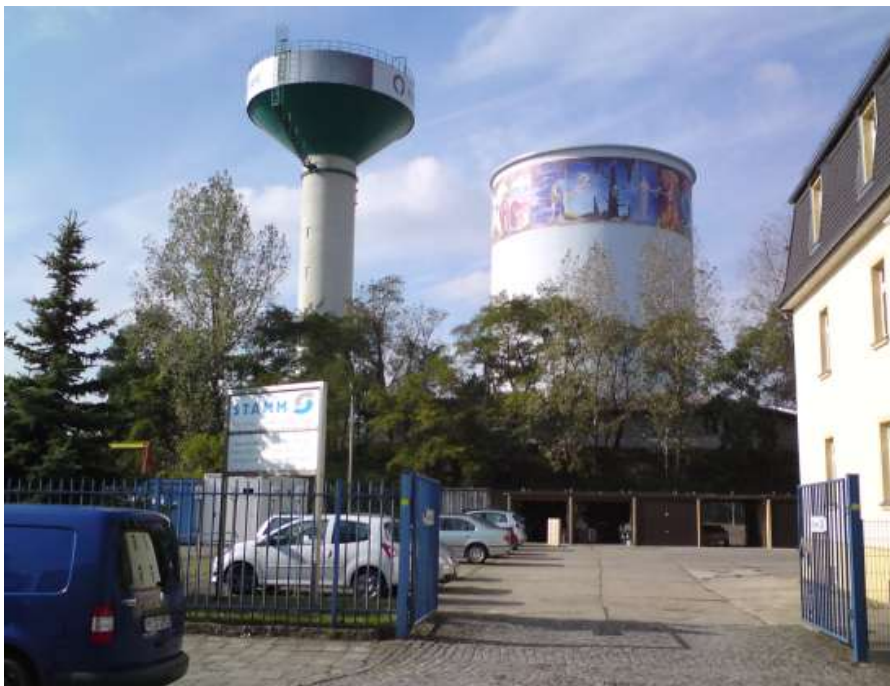
Abb. 5: Abgeschlossene Bauarbeiten am Kühlturm am 02.10.2012 (Foto: Pflingstmann, BfUL)
