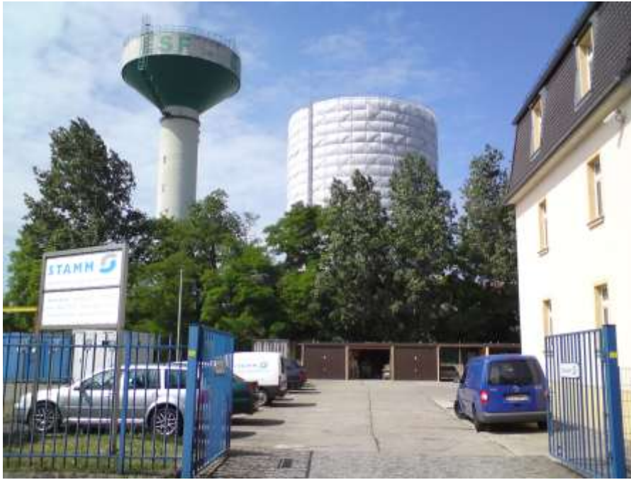
Abb. 4: Bauarbeiten am Kühlturm in unmittelbarer Nähe des Messpunktes am 30.05.2012 (Foto: Pflingstmann, BfUL)
