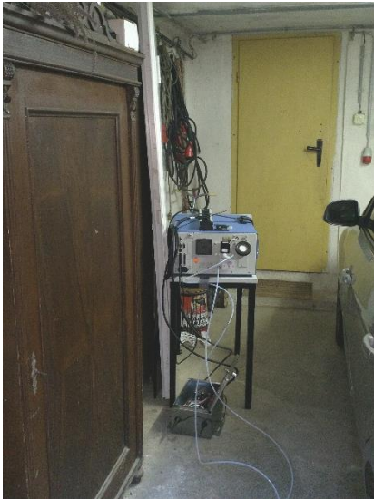
Abb.2: Aufstellungsort des Ozonmessgerätes in der Garage
